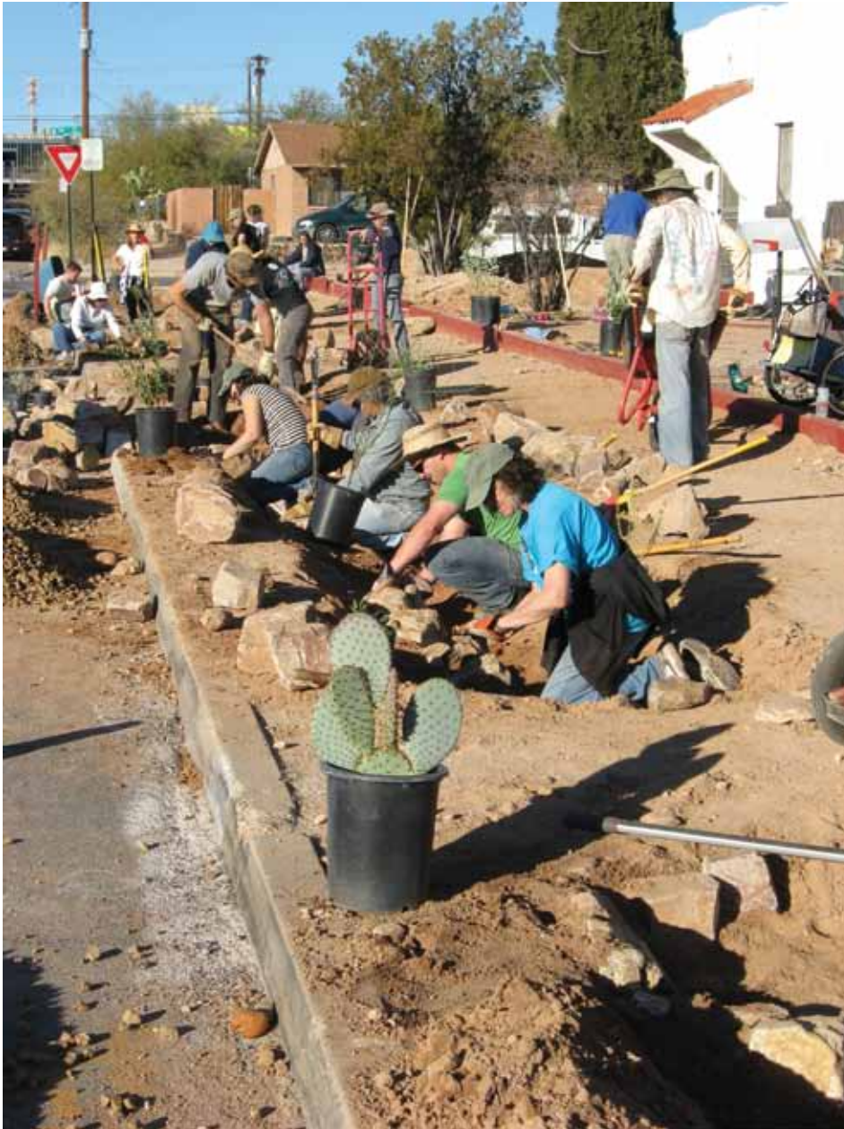
Voluntarios instalando zanjas de bioretención en un derecho de vía en un taller en Tucson (arriba) y La Paz (derecha) coordinado por Watershed Management Group.
